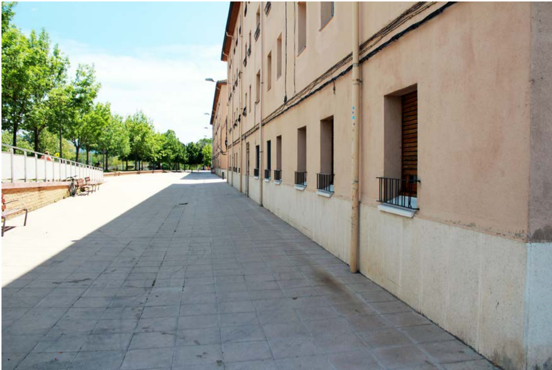
Els Habitatges Montseny del barri del Remei
